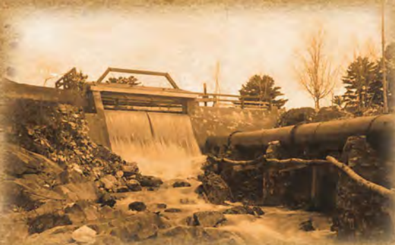
Tuyau du moulin
